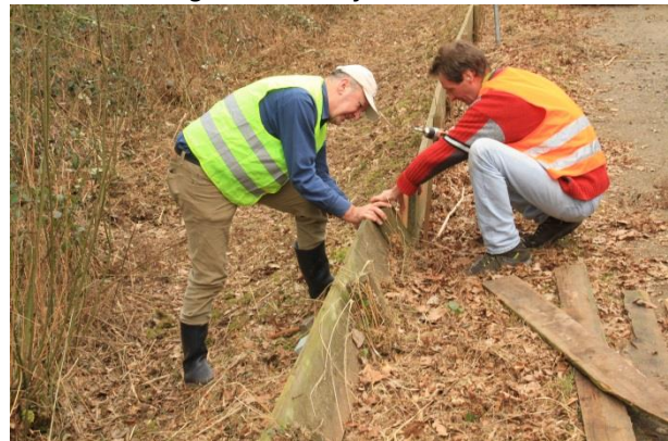
defekte Zaunteile reparieren oder erneuern
