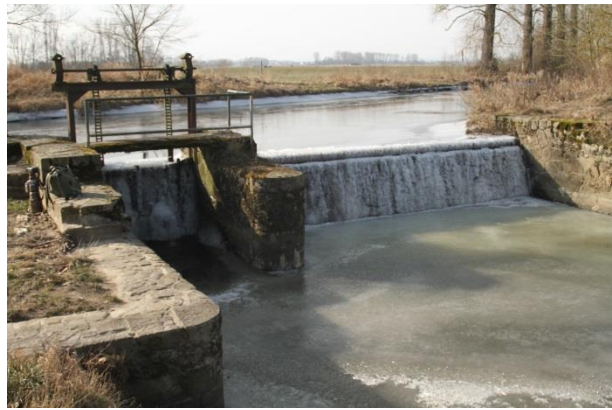
Vereistes Gersprenzwehr bei Hergershausen
